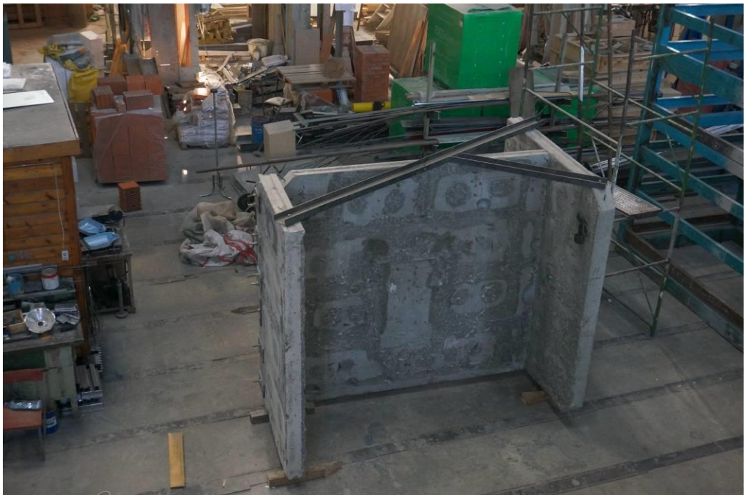
Рис. 1.1 Общий вид пространственного экспериментального фрагмента из сборных железобетонных панелей
