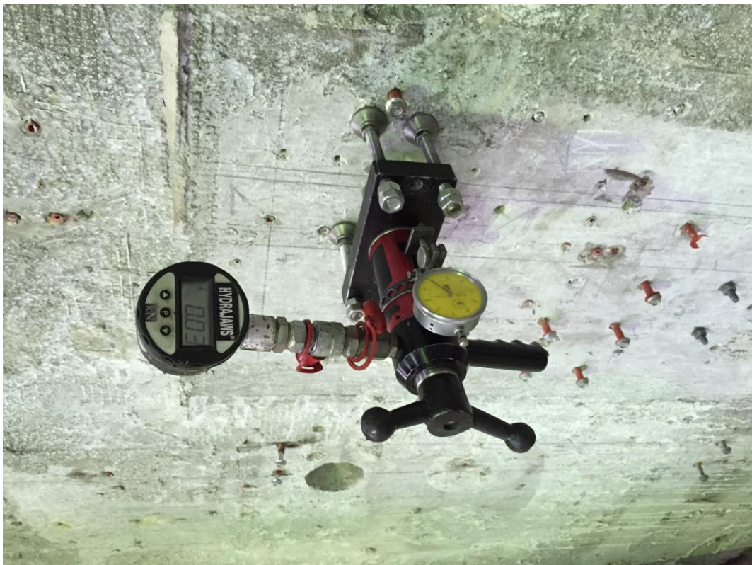
Рис. 4.4 Общий вид домкратной установки для испытаний анкеров на вырыв
