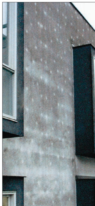
Рис. 5. Пример появления пятен на фасаде в местах расположения дюбелей («эффект леопарда», фото из статьи [1])
